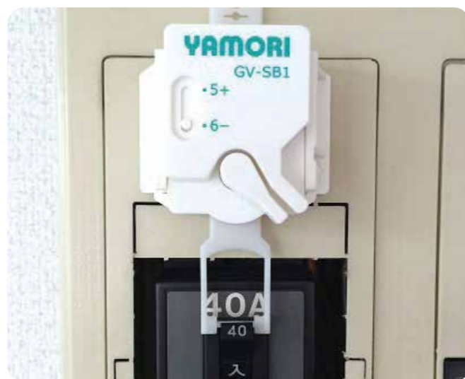
地震を感知すると自動的にブレーカーを落として電気を止める「感震ブレーカー」。助成対象になると約2000円の設置費用だけで設置できる。
